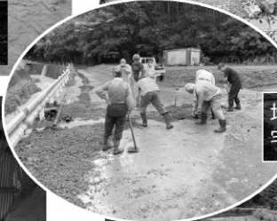
瀬戸川中流域(助宗)の護岸が100m崩落。あとわずかで堤防が決壊するところだった
